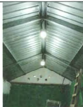
Foto 2: Instalación de estructura de metal con sus respectivo sistema electrico mejorado y alumbrado.
