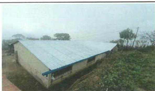
Foto 5: Instalación de lámina troquelada con sus respectivos capotes y elementos de fijación (aula).
