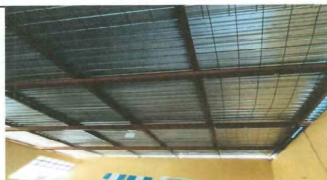
Foto 6: Instalación de cubierta de lamina troquelada(aula) para mejorar las condiciones del ambiente.
