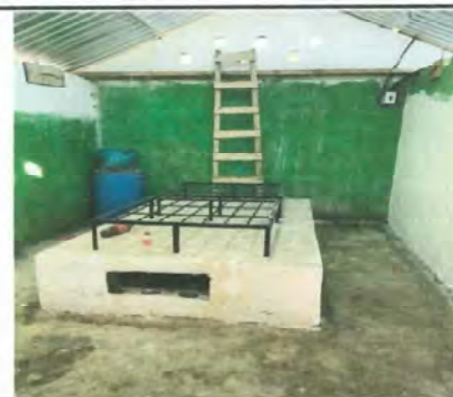
Foto 4: Elaboración de polleton con sus respectivas parrillas metalicas.
