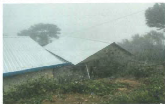
Foto 1: Instalación de lamina troquelada en ambiente de cocina para mejorar las condiciones de dicho ambiente.
