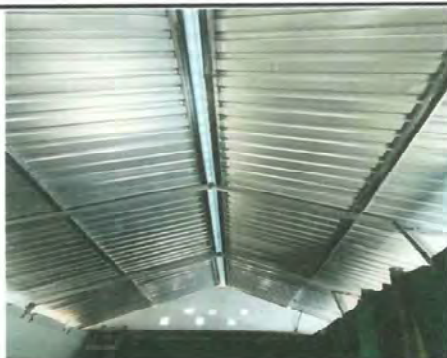
Foto 4: Mejoramiento de cubierta de lámina (techo) y estructura metalica area de cocina.
