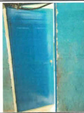
Foto 8: Instalacion de puerta metalica con area de cocina.
