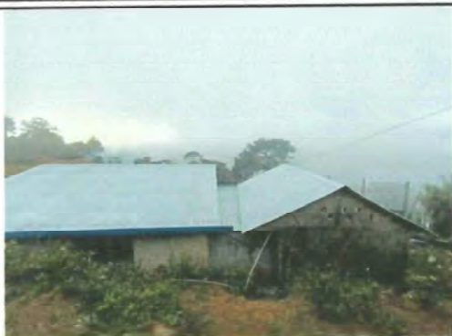
Foto 7: Instalacion de canal metalico con sus respectivos elementos de soporte (pescantes).
